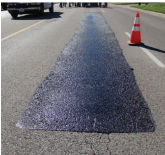
Reparación de superficies
