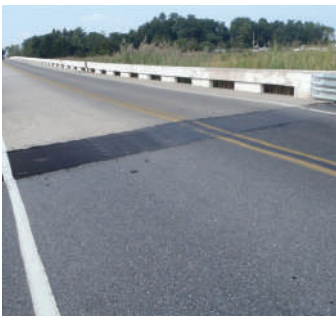
Acercamiento de cubierta del puente
